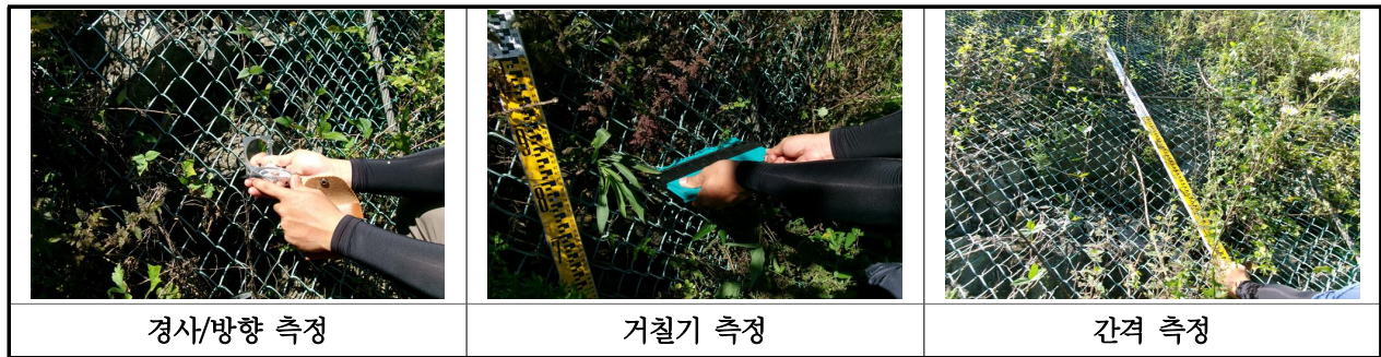
【사진 20.3.2】 불연속면 측정 현황
